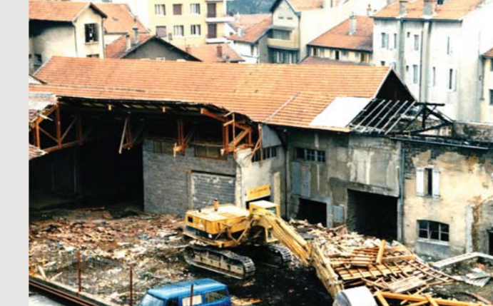
Destruction de l'ancienne scierie
