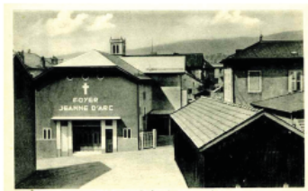
BELLEGARDE (Ain) — Le site patrimonial Foyer Jeanne d'Arc, 1950
