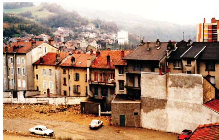
Nivellement du terrain, 1989
