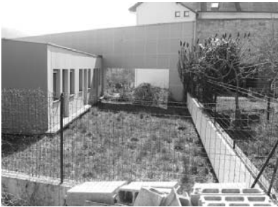
Toiture terrasse sur la MJC, source: photo personnelle
