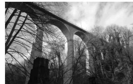
Pont ferroviaire en 2011, vue depuis la Valserine, source: photo personnelle
