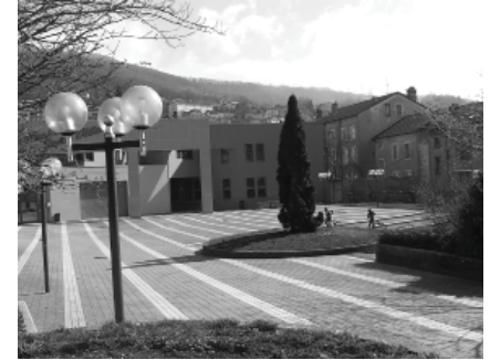
Vue générale de la place
