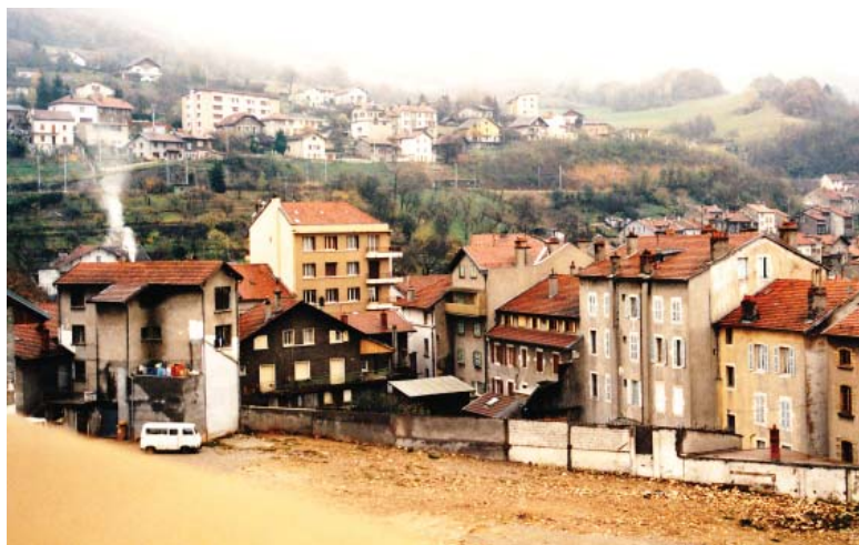
Nivellement du terrain, 1989
