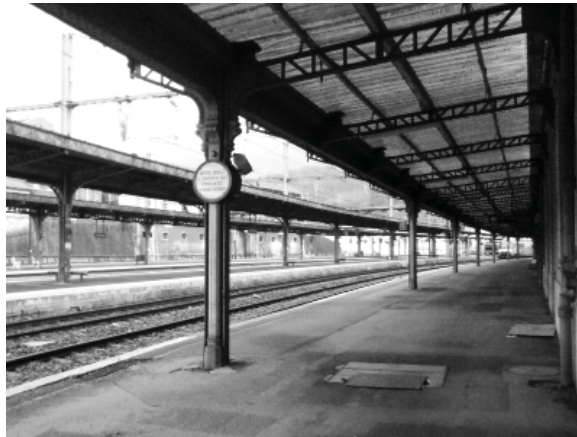
Quai de la gare délaissé, 2011, source: photo personnelle
