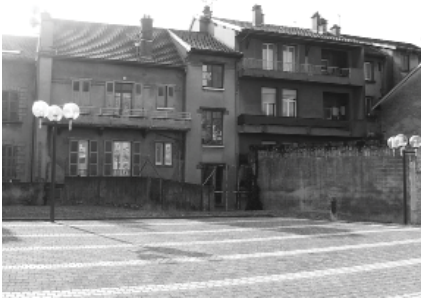
Vue sur les luminaires et le bâti privé
