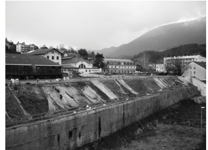
Futur emplacement du collège dans le talus SNCF, source: photo personnelle
